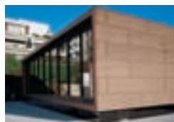
Banca BTV, Innsbruck, A Hanno Vogl-Fernheim, Innsbruck Spenglerei & Glaserei Anker, Hall TECU® Net Bronze
