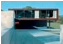
Roche Forum, Buonas, CH Scheitlin + Syfrig, Lucerna Gebr. Baur AG, Baar TECU® Oxid
