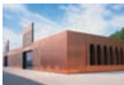
Centro servizi Theresienwiese, Monaco di Baviera, D Volker Staab Architekten, Berlino Regensburger Metallbau, Regensburg TECU® Classic
