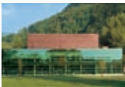
Edificio per uffici e attività produttive della Elektro Graf, Dornbirn, A Baumschlager & Eberle, Lochau Güther GmbH, Feuchtwangen, D TECU® Oxid
