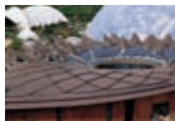
THE CORE, Centro informazioni per il Progetto Eden in Cornovaglia, GB Nicholas Grimshaw & Partners, Londra Richardson Roofing Co. Ltd., Staines TECU® Classic
