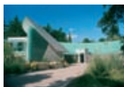
Edificio residenziale «Thunderbird», Poole, GB Seven Developments Ltd., Poole Pace Roofing Ltd., Romsey TECU® Patina
