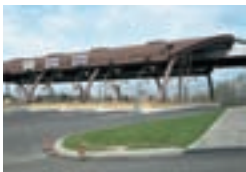
Casello autostradale, Lucca, I Ettore Piras Architetto, Genova Trenkwalder S.r.l., Ovada (AL) TECU® Oxid
