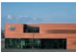
Edificio per uffici e attività industriali, Koblach, A AIX Architects, Feldkirch Peter GesMBH + CoKG, Koblach TECU® Classic
