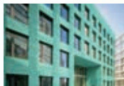
Edificio per uffici e attività commerciali «KAI 13», Düsseldorf, D Döring Dahmen Joeressen Architekten, Düsseldorf Zitzen GmbH, Mönchengladbach TECU® Patina
