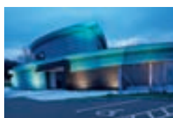
Centro cura oncologico «Maggie's Highlands», Ospedale di Raigmore, Inverness, GB Page & Park Architects, Glasgow W B Watson Ltd., Stewarton TECU® Patina, TECU® Oxid
