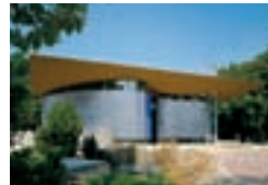
Cappella del cimitero «St. Maria der Engelen», Rotterdam, NL Mecanoo architecten, Delft Leidekkersbedrijf Jobse BV, Middelburg TECU® Zinn
