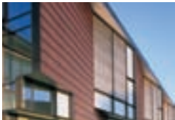
Edificio per uffici e attività produttive, Baar, CH Burkart, Bauabteilung Baar; Barkow Leibinger Architekten, Berlino Gebr. Baur AG, Baar TECU® Oxid
