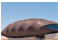
Parque de la Relajación, Torre Vieja, E Toyo Ito & Associates, Tokyo, J; Toyo Ito Spain & Associates, Alicante, E Vicente Escolano, Novelda, Alicante TECU® Oxid
