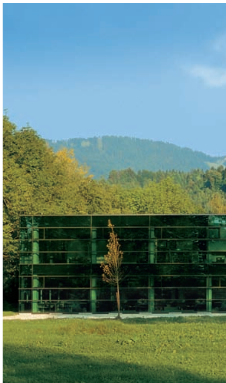
Edificio per uffici e attività produttive della Elektro Graf, Dornbirn, A Architetti: Baumschlager & Eberle, Lochau Installatore: Güther GmbH, Feuchtwangen, D Tipo di rivestimento: TECU® Oxid
