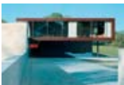
Roche Forum, Buonas, CH Scheitlin + Syfrig, Lucerna Gebr. Baur AG, Baar TECU® Oxid
