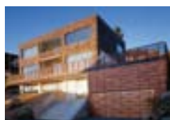
Abitazione privata, Affoltern am Albis, CH Deon AG, Lucerna W.O.B. GmbH, Wolfenschiessen TECU® Net Classic
