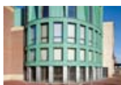
«Boscotondo», Helmond, NL Adolfo Natalini Architetti, Firenze Architectenburo C. Schrauwen, Amsterdam Crombach Dakafwerking BV, Wittem TECU® Patina
