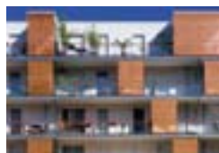
Complesso residenziale «Le Galilée», Rennes, F Chouzenoux et Associés, Rennes SABM, Guichen TECU® Net Classic
