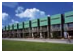
Complesso residenziale, Purmerend, NL Roy Gelders Architecten, Amsterdam Ridder Dak- en Wandsystemen BV, Hoorn TECU® Patina
