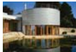
Abitazione privata, Herrliberg, CH R. Baenziger, Zurigo Hersperger, Meilen ((facciate); Studer AG, Volketswil ((lattoneria) TECU® Zinn
