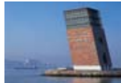
Torre di Controllo del Porto di Lisbona, P Gonçalo Byrne, G.B. Arquitectos, Lisbona Zn-Revestimentos de Zinco Lda., Maia TECU® Classic
