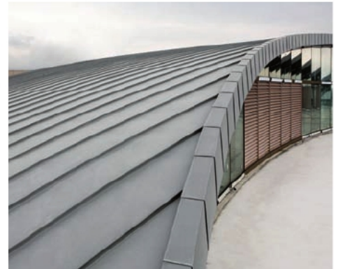
Dida: Università culturale cinese, Taipei (Taiwan) Architetto: JJ Pan e partners Installatore: Bluescope Lysaght
